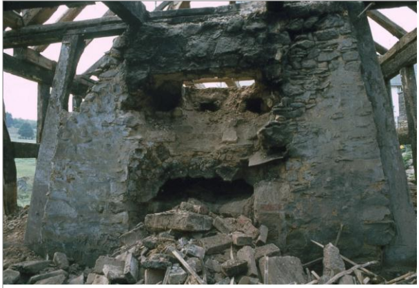
Abbildung 5: der Original Backofen während des Abrisses. Oben der Rauchabzug, unten ist das Mundloch des Backofens zu sehen. ©Freilichtmuseum Hessenpark, Neu Anspach, Repr Erwin Schön.
