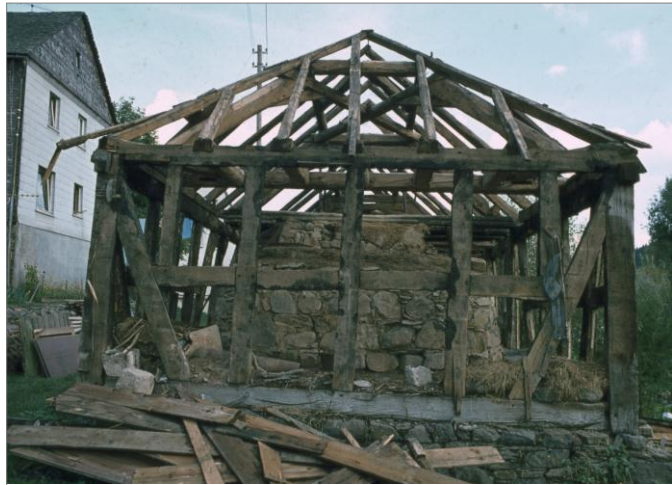
Abbildung 4: Hier ist das Ausmaß des Backofens gut zu erkennen, ebenso die Basaltsteine. Die vom Brand geschwärzten Balken sind gleichfalls zu sehen. ©Freilichtmuseum Hessenpark, Neu Anspach, Repro Erwin Schön.
