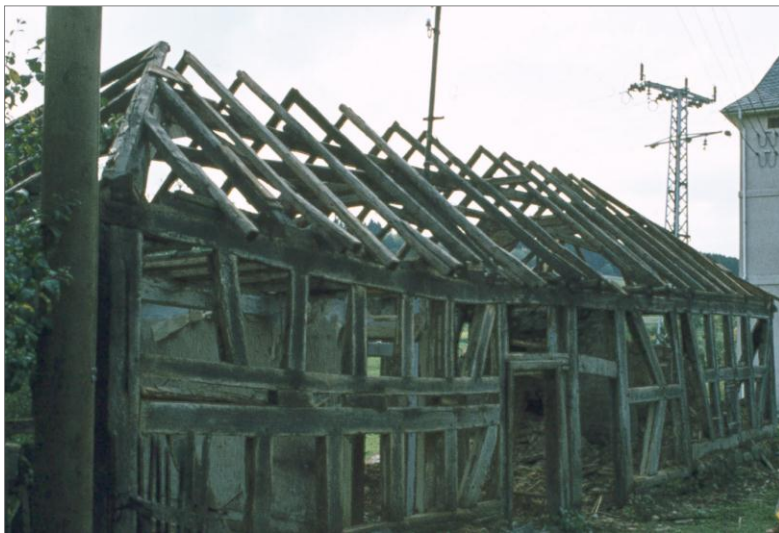
Abbildung 3: Holzskelett während des Abbaus, ©Freilichtmuseum Hessenpark, Neu Anspach, Rebro Erwin Schön.
